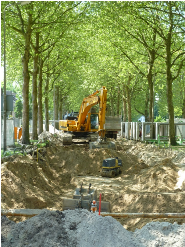
Fig. 2 Aanleg riool en retentiebekken in de Beatrixlaan in 2013
