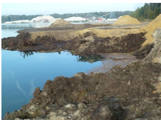
Fig. 4 Daar waar nu het strand moet komen is in het najaar 2014 84.000m 3 nutriëntenrijke grond afkomstig van de Kruispeel gestort (foto 12-10-2014).
